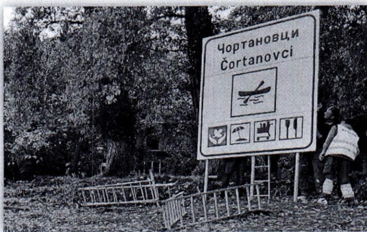
Слика бр. 5: Постављање знака наутичке сигнализације на обали Дунава у Чортановцима
